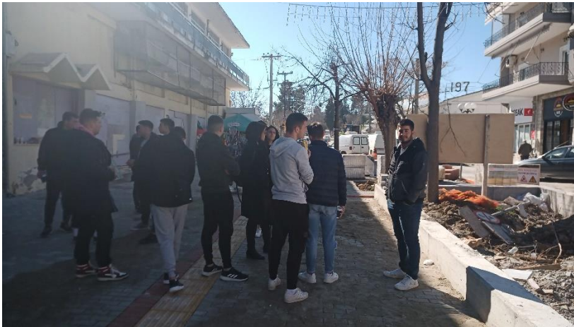
Εικόνα 1: Επίσκεψη στον υπό κατασκευή πεζόδρομο του Βελεστίνου
