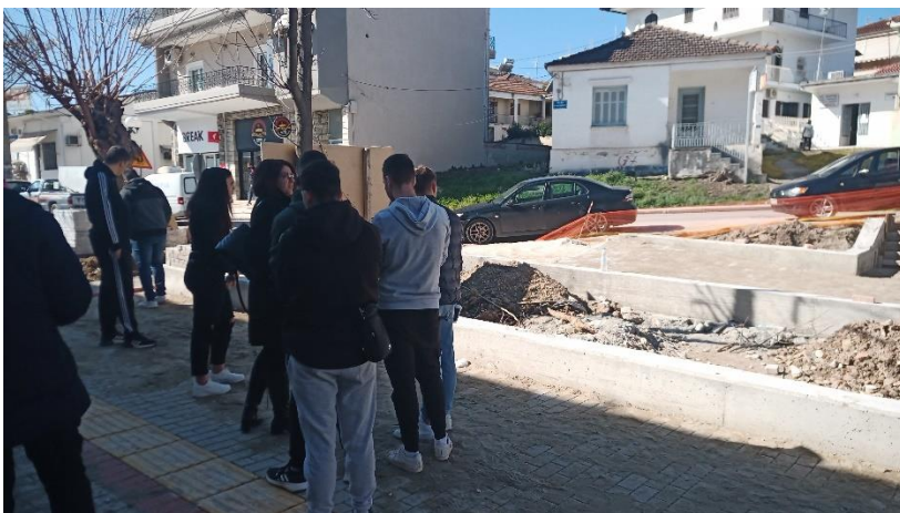
Εικόνα 2: Επίσκεψη στον υπό κατασκευή πεζόδρομο του Βελεστίνου
